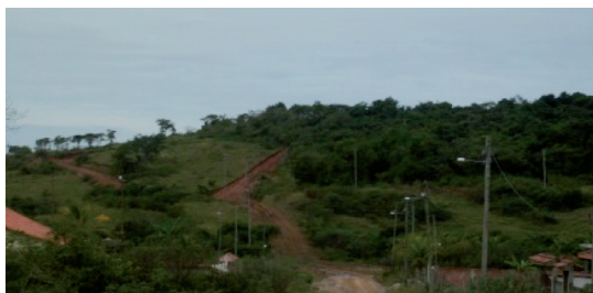
Estradas sendo abertas
