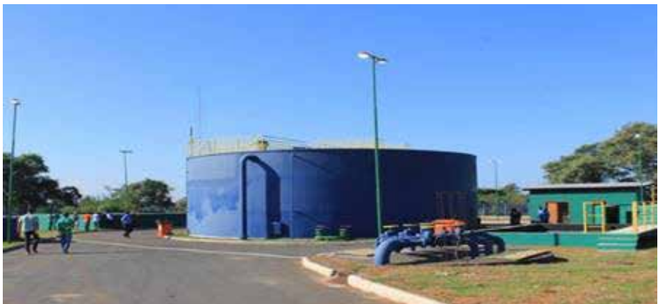
Fotos 22 e 23: Sistema de Esgotamento Sanitário da Prolagos em Arraial do Cabo. Fotos: acervo Prolagos.
