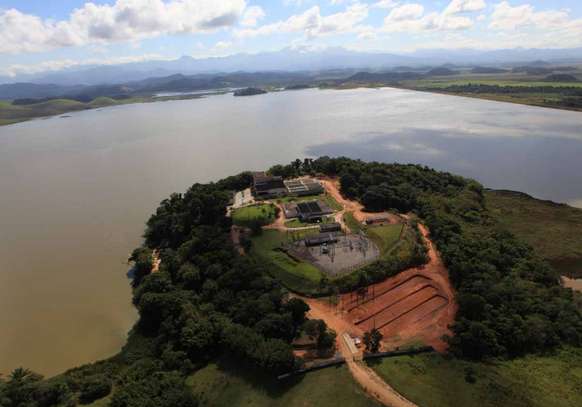
Foto 9 – Local da ETA Juturnaíba. Foto: Acervo Águas de Juturnaíba
